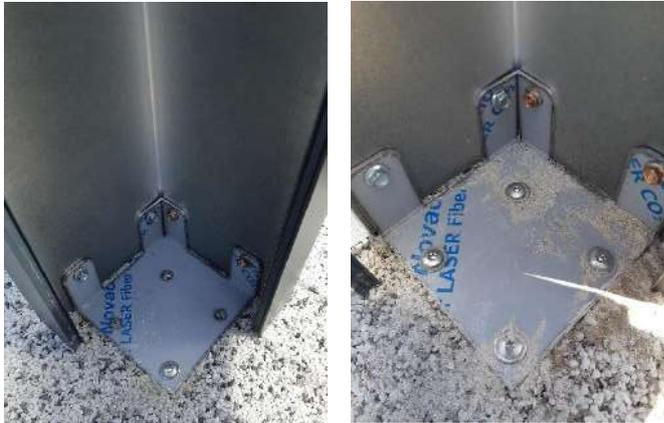
Positionner le pied de poteau et le fixer par l'intérieur au poteau avec des Vis de 6.3\*16 ; puis réaliser la fixation au sol en l'adaptant au support.
