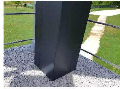
**16-Installation des profils LED :** doit venir à fleur, en bas, et se clipse directement sur la poutre sablière.
