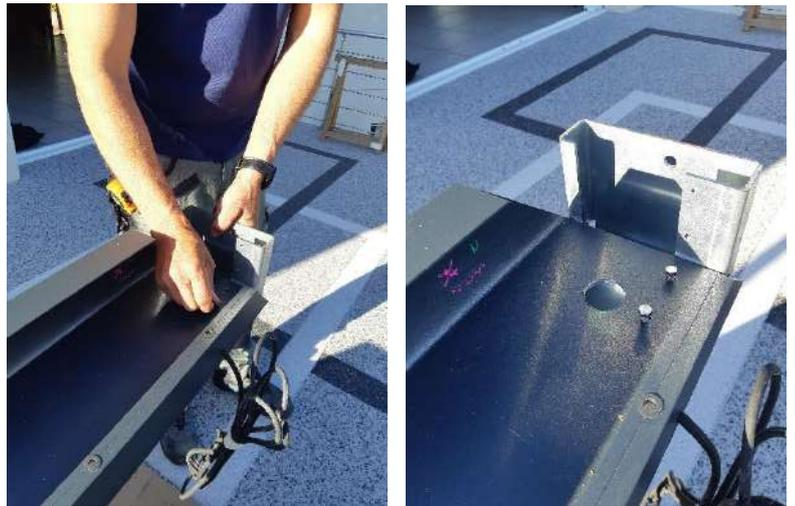
2- **Mettre en place la poutre muralière** à hauteur en contrôlant le niveau. S'aider d'étais si besoin.
