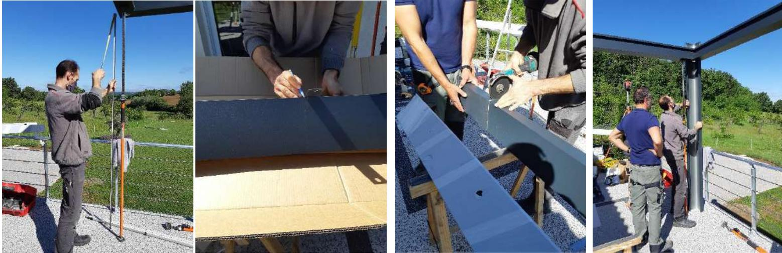
Réaliser une découpe en partie basse pour l'évacuation de l'eau, uniquement dans les poteaux prévus pour évacuer l'eau ; ou tuber si c'est la solution choisie.
